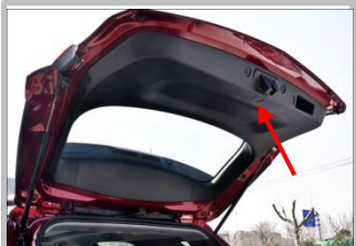
3.16 接门锁信号线：拆下原车尾门上盖板后，看到原车门锁连接器；
